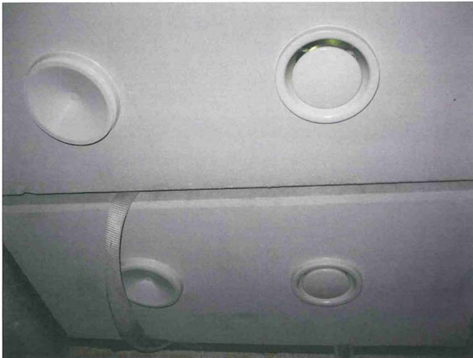
Kuva 4. Laattaan asennetut koekappaleet asennusvaiheessa ennen palonkestävyyskoetta.
