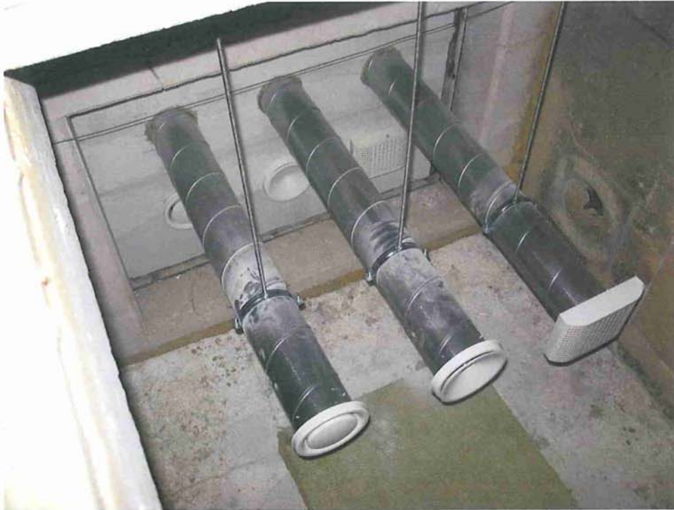
Kuva 1. Seinään asennetut koekappaleet uunin puolelta ennen palonkestävyyskoetta.
